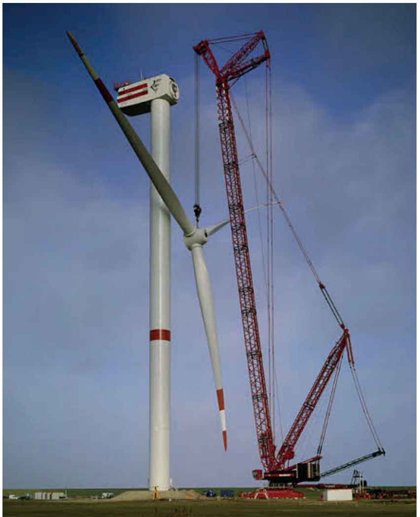
Kuva 13. Tuulivoimalan pystytys tela-alustaisella nosturilla (Liebherr 2012b).
