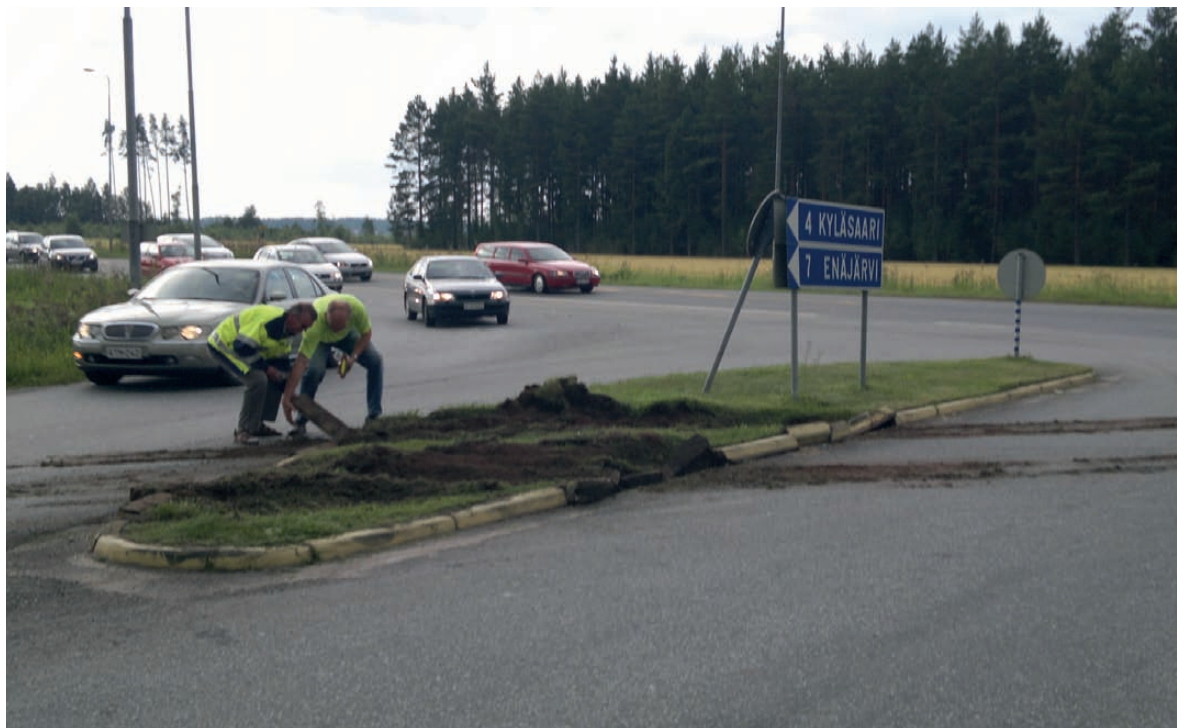
Bild 15. Exempel på mittrefug som inte lämpar sig för specialtransporter (Bild: Tomi Alho, ELY-centralen i Birkaland).
