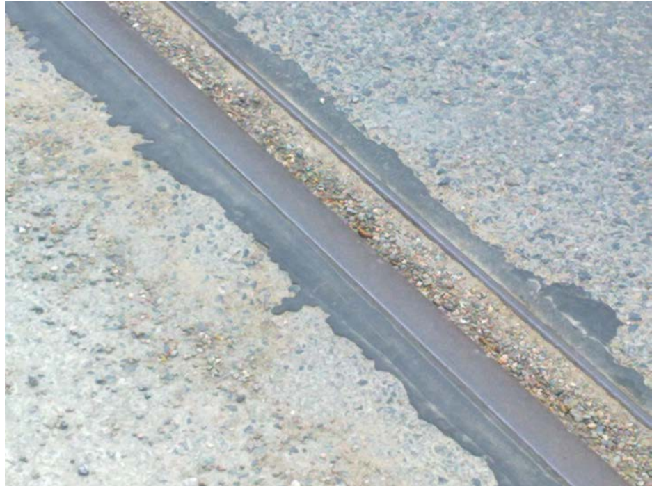
Kuva 12. Lähikuva hiekalla täyttyneestä metron huoltoraiteesta
